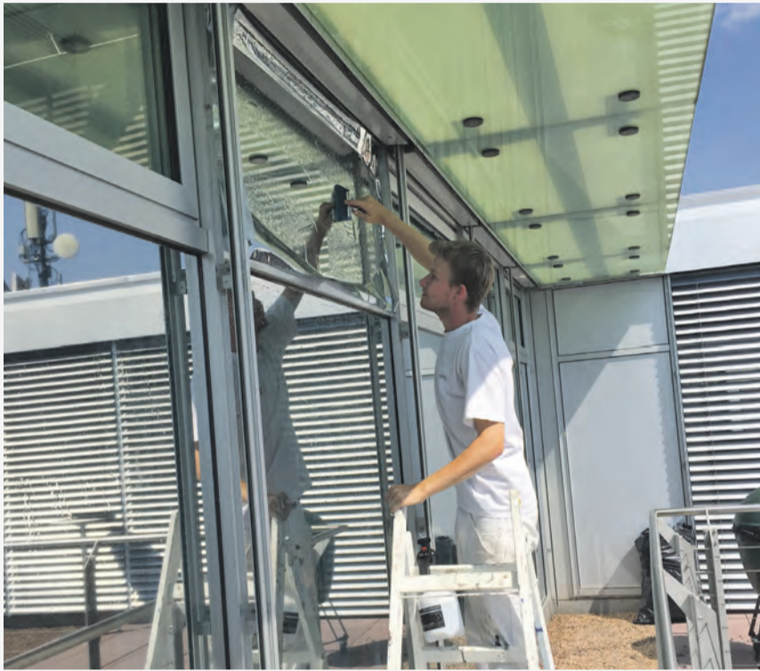
Montage der Fensterfolie.
