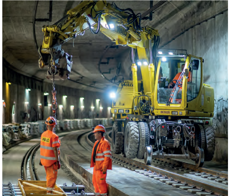
Bauarbeiten im Sihltunnel zwischen der Station Selnau und dem Tunnelportal.
