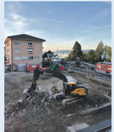
Hier entsteht Thalwils neuer Dorfplatz.
