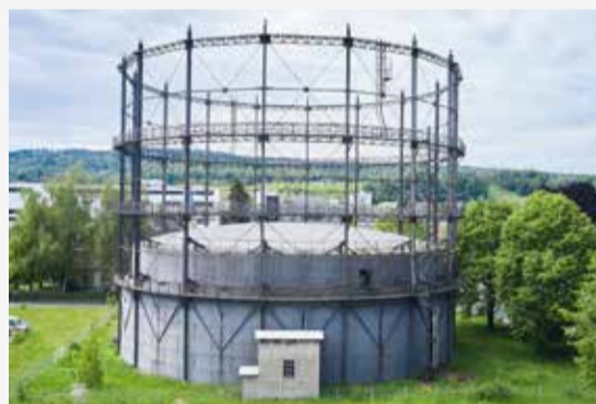
Das Gasnetz soll stillgelegt werden.
