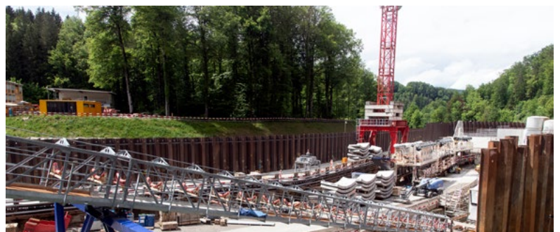
Imposante Baustelle: Ab 2026 ist der Entlastungsstollen zum Zürichsee vor Thalwil bereit, Hochwasserspitzen abzufangen.
