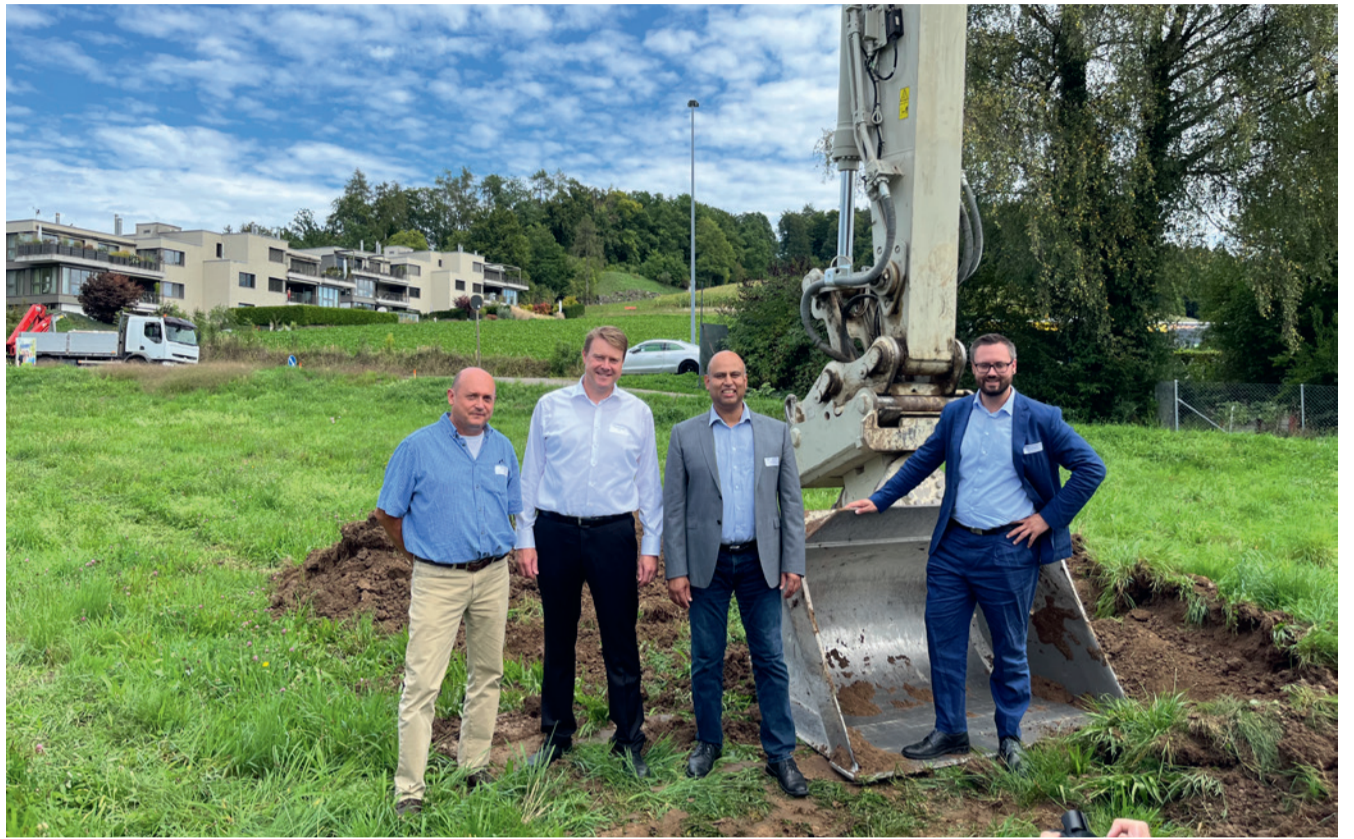
Erster Spatenstich mit (v.l.n.r.): Heinz Horner (Leiter Planung und Bau Anlagen EKZ), Daniel Bucher (Leiter Netze EKZ und Mitglieder der GL), Jean-Philippe Pinto, (Gemeindepräsident Volketswil und Kantonsrat) und Michael De Vita (Gemeinderat Volketswil).
