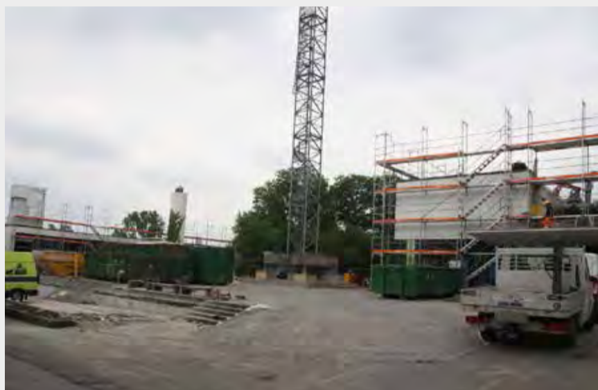
Bereits laufen die Bauarbeiten im Hellwies mit vollem Einsatz aller Beteiligten.
