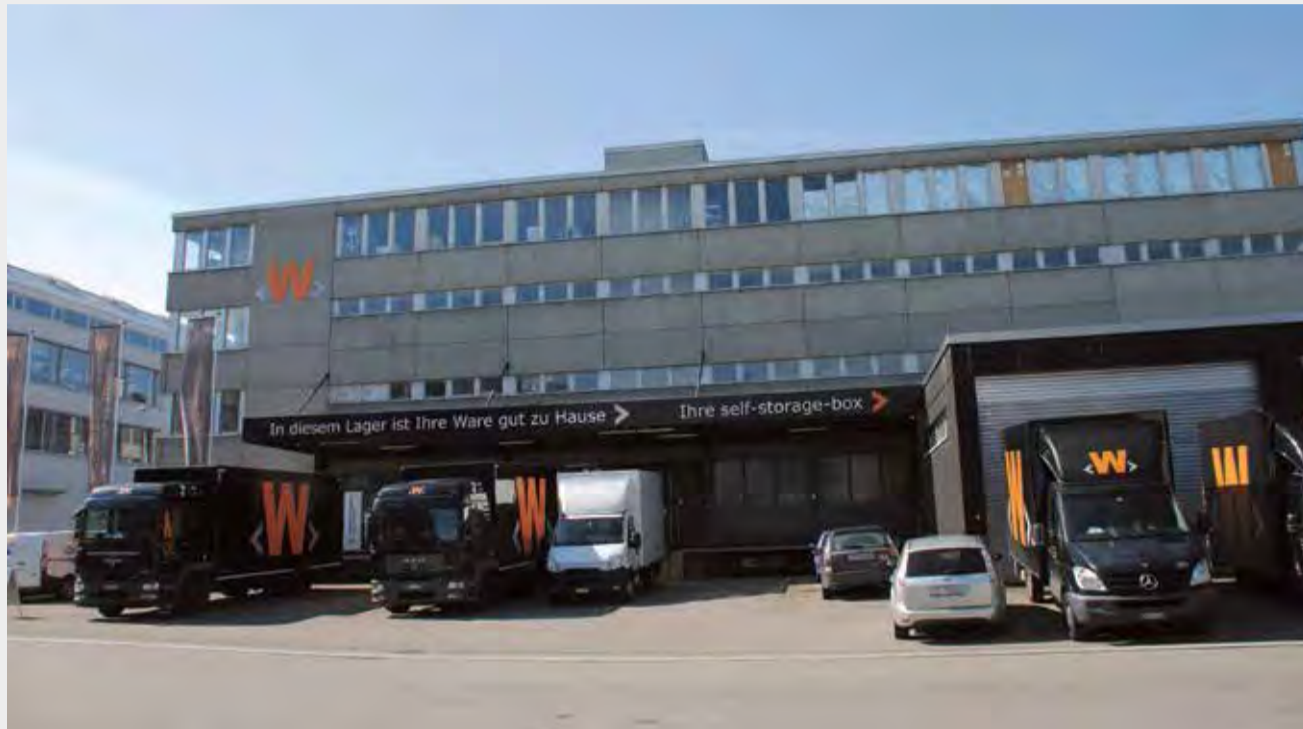
Das Wiedmer-Gebäude in Fällanden.
