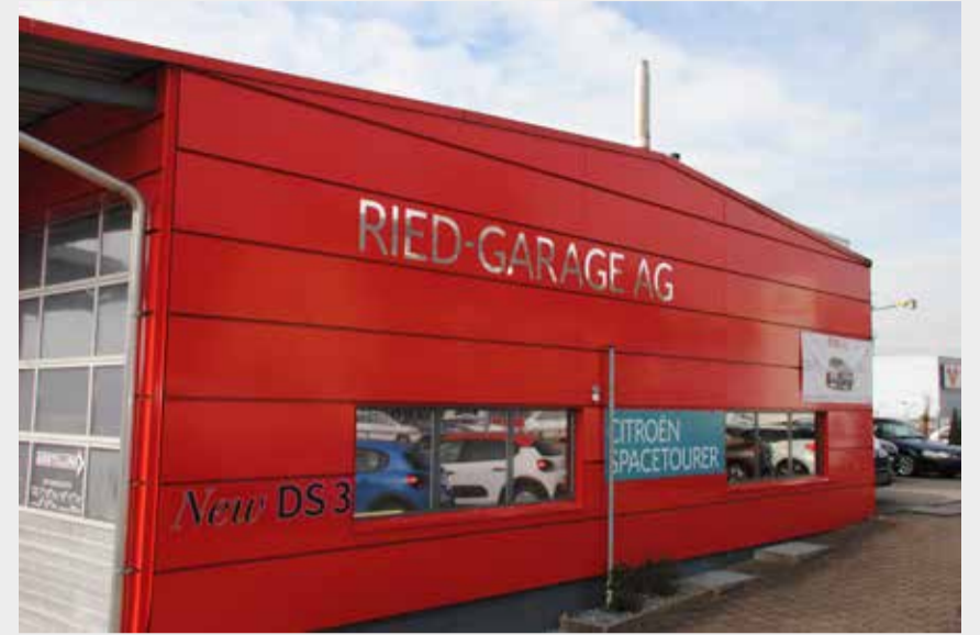
Die Ried-Garage ist nicht zu übersehen.
