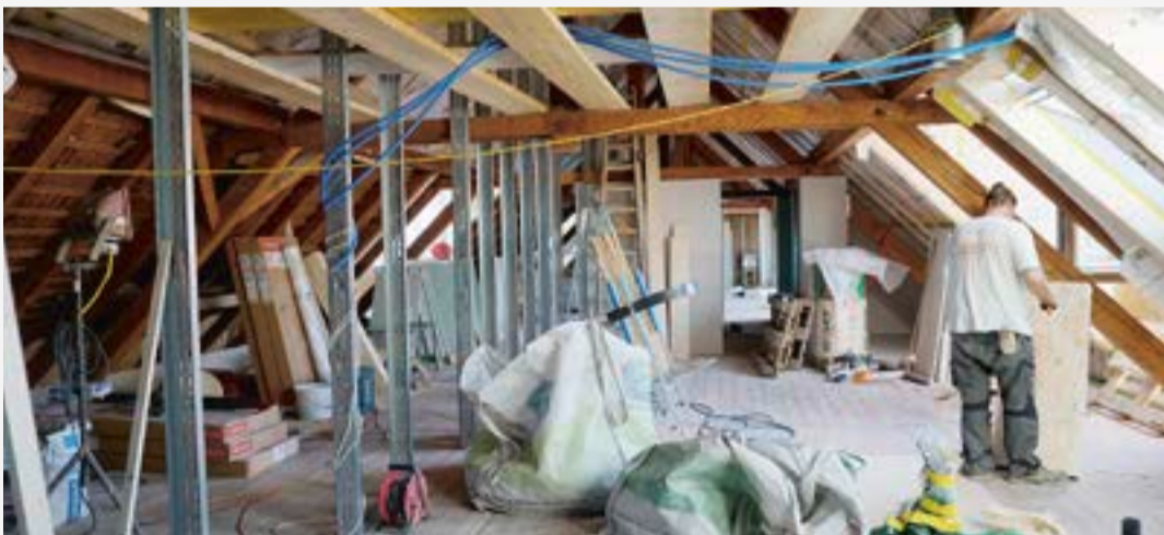
Der Ausbau des Estrichs ist noch im Gang.
