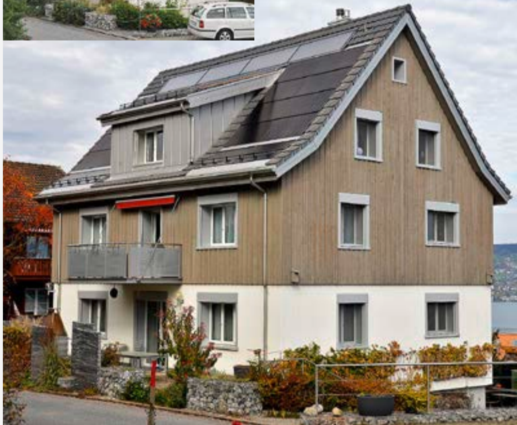
Modernisiertes Mehrfamilienhaus an der Mühlebachstrasse mit Solarstrom-Eigenverbrauchsgemeinschaft
